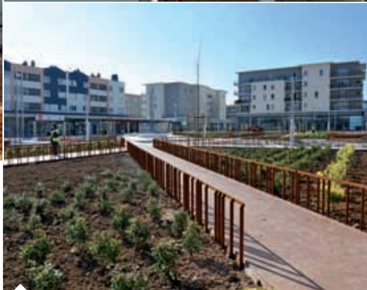
Le renouvellement urbain de la Grâce-de-Dieu se termine : la place du Commerce retrouve sa vocation de lieu de vie.
